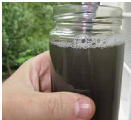
Sisäyksikön syväpuhdistus paljastaa lian määrän
